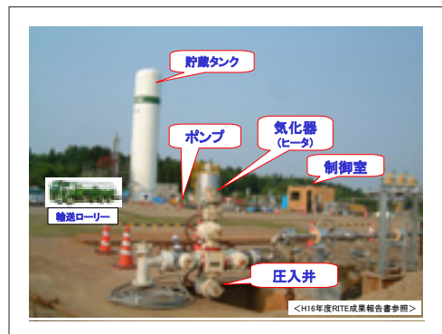
写真1 CO 2 地中貯留圧入実証試験の地上施設
